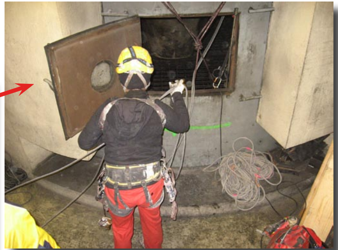
Trappe d'accès des puits
