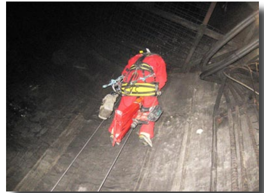
Descente de la potence d'accroche du scanner
