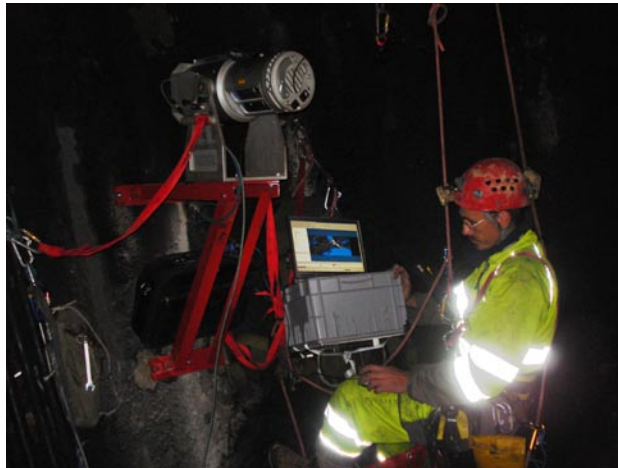
Poste de travail en milieu de puits
